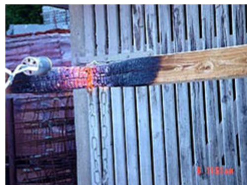
Der Brandfortschritt im Lastbereich wird sichtbar.
