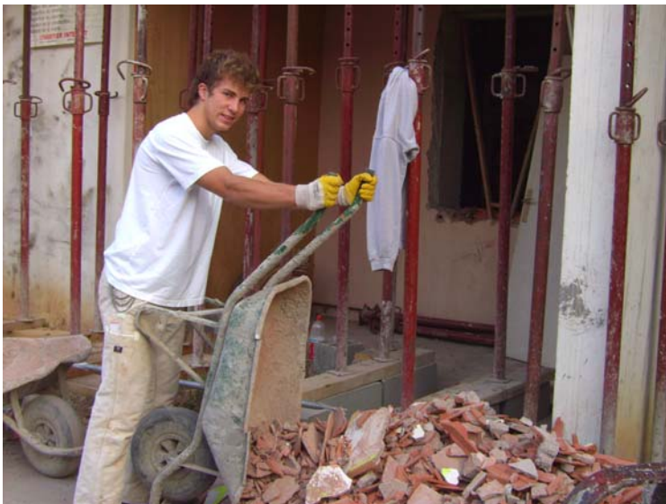
Tim bei Abrissarbeiten eines späteren Altenwohnheims
