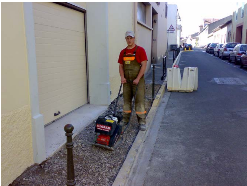
Sven beim Verdichten des Untergrundes mit der Rüttelplatte
