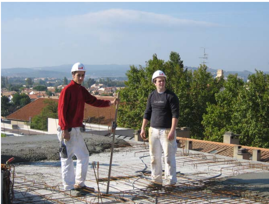
Fabio und Tristan bei den Betonierarbeiten
