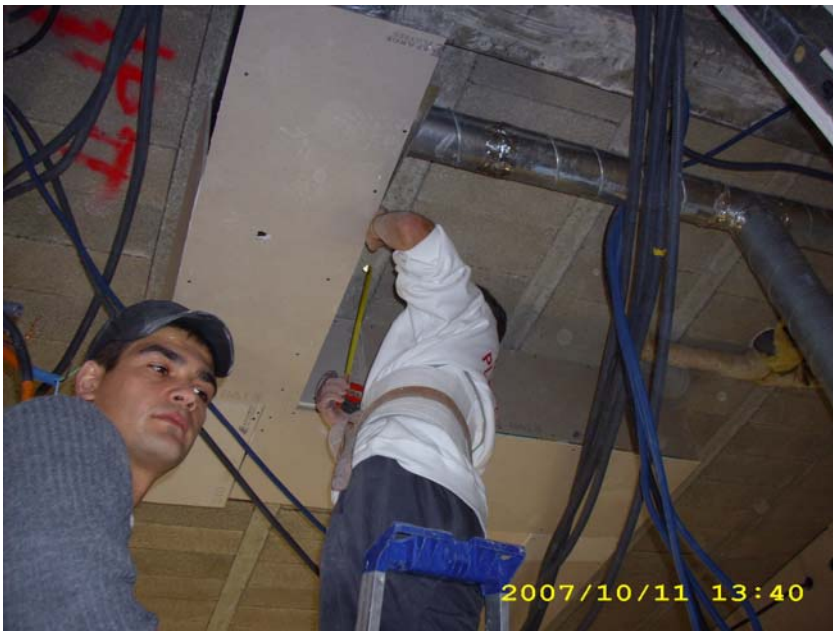
Andreas im Vordergrund, der französische Mitarbeiter bei Deckenarbeiten
