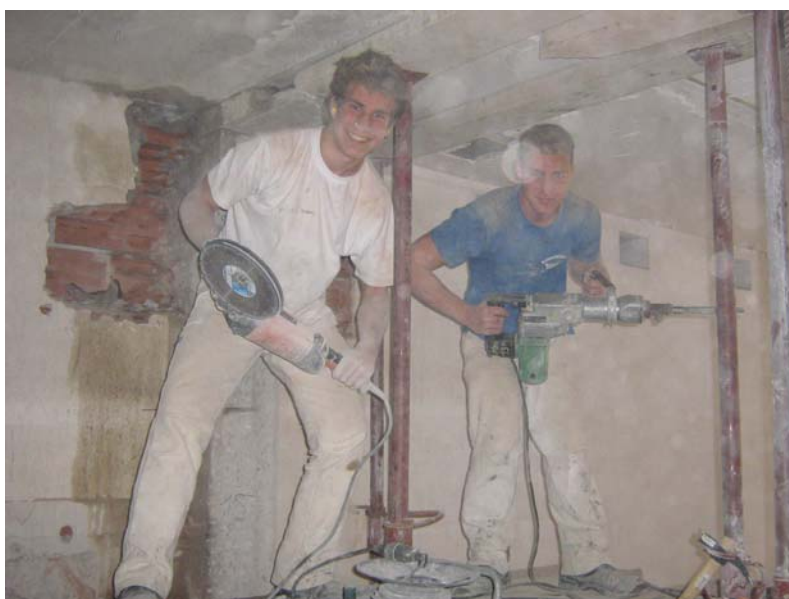
Alexander bei Stemm- und Abrissarbeiten
