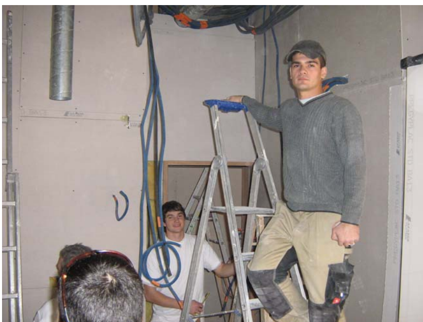
Andreas und Waldemar bei Sanierungsarbeiten
