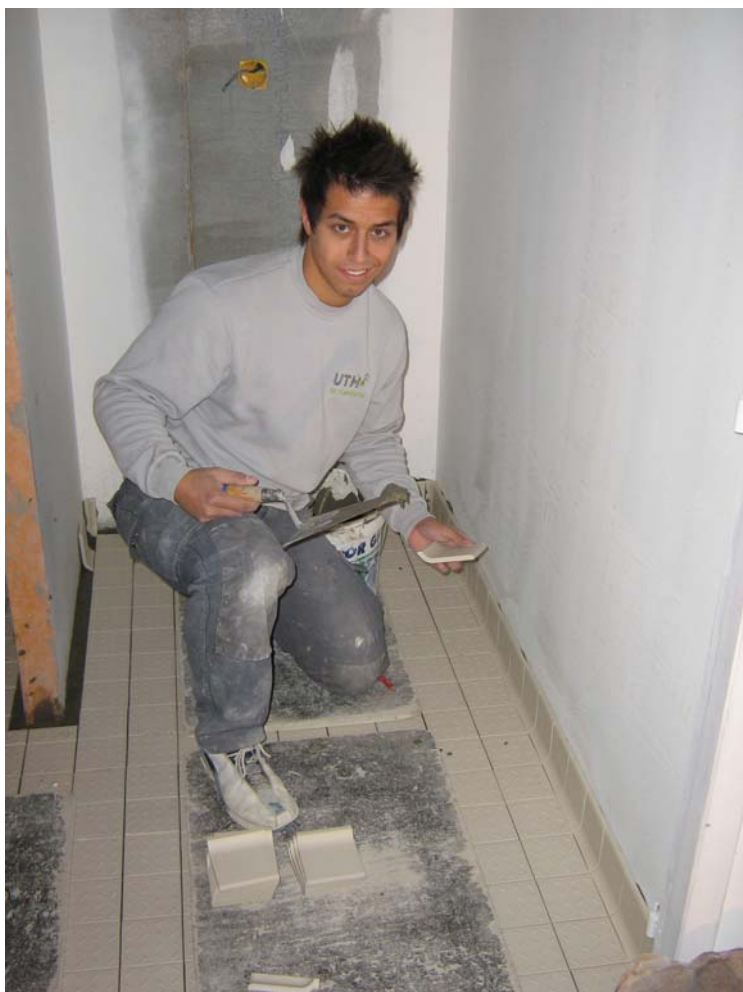
Marco in einem Neubau (Krankenhaus) außerhalb Narbonnes
