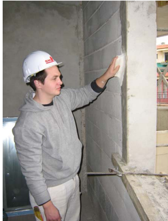
Tristan bei Spachtelarbeiten
