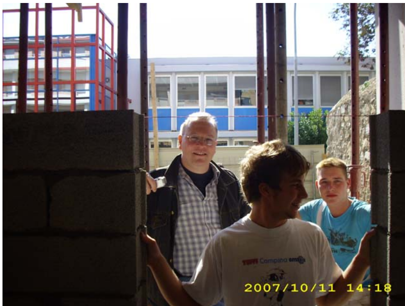
Alexander und Tim bei den Mauerarbeiten
