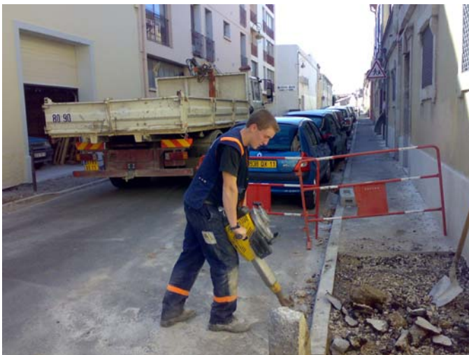
Timo Steinhauer bei Stemmarbeiten in den Gassen von Narbonne.
