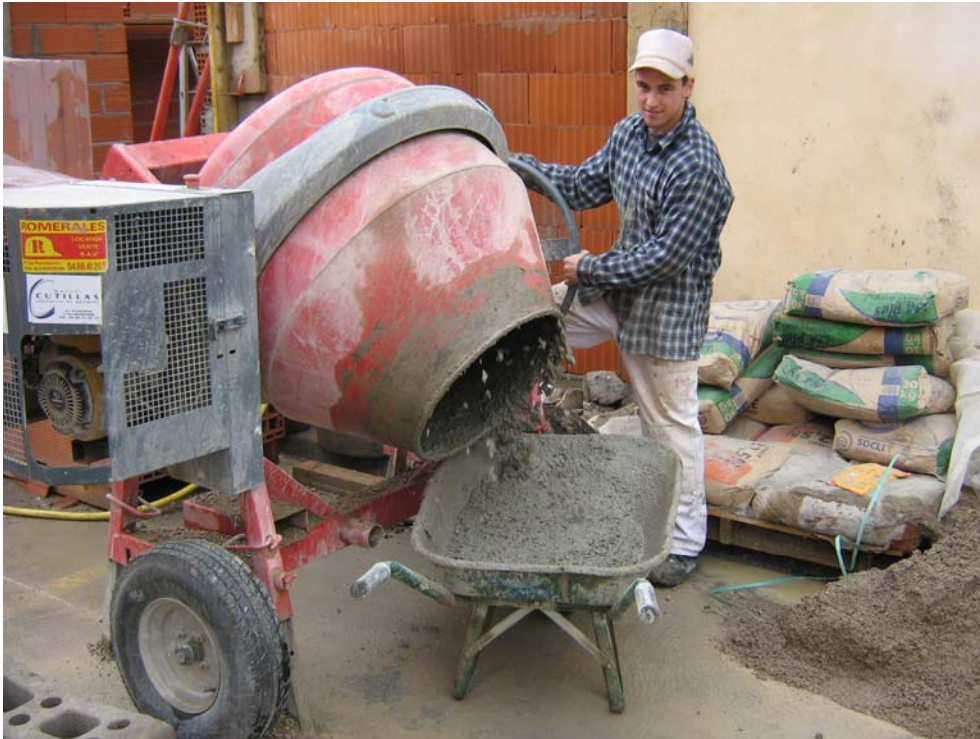
Daniel beim Herstellen von Beton
