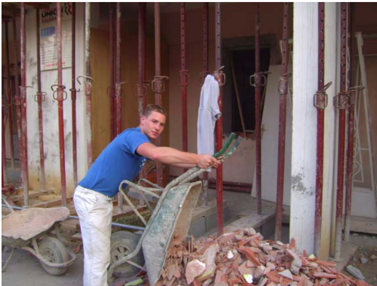
Alexander bei Abrissarbeiten eines späteren Altenwohnheims
